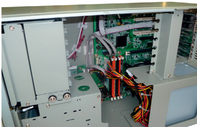
Рис. 3. Аккуратная укладка кабелей внутри IPC-ATX-7220-A7/W7
