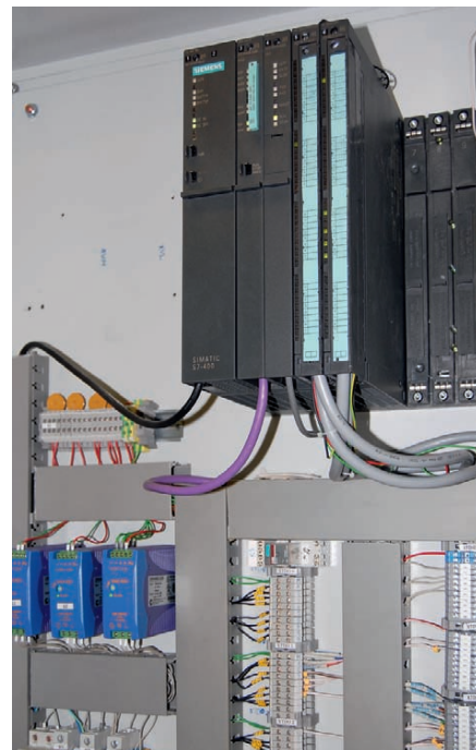
Рис. 3. Контроллер SIMATIC S7-414-2 в составе оборудования системы управления ЦГП
