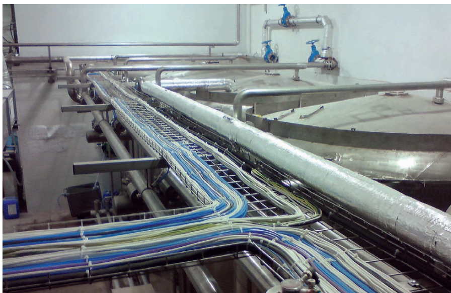
Рис. 3. Станция мойки, вид сверху
