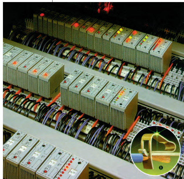
Рис. 2. Электронные модули, устанавливаемые на рельсы типа DIN-35
