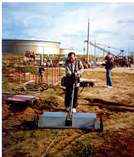
Рис. 4. Исследование коммуникаций на нефтеперерабатывающем предприятии
