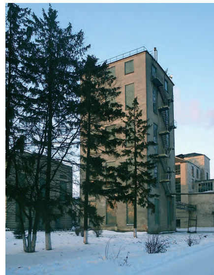
Козловский спиртовой завод, здание брагоректификационной установки
