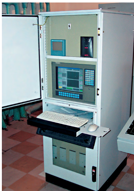
Рис. 2. Общий вид рабочего места оператора пресса
