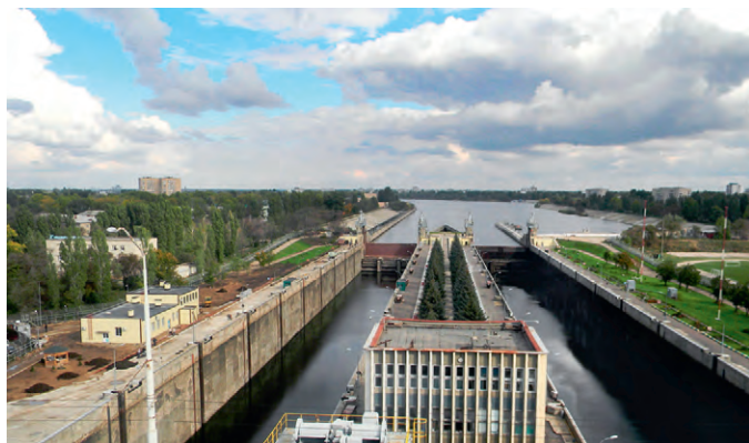
Рис. 3. Вид на шлюзы с поста управления
