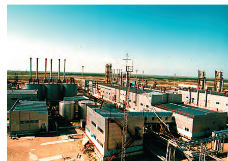
Установка комплексной подготовки газа
