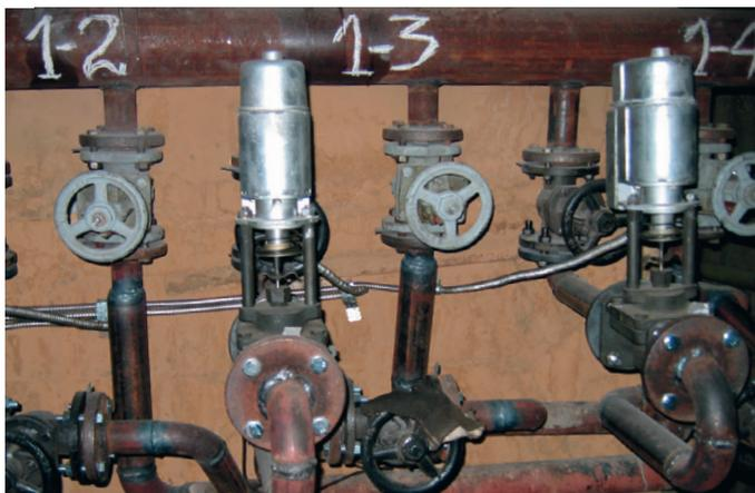
Рис. 4. Электроклапаны, установленные на паропроводе
