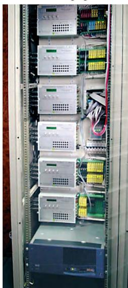
Рис. 7. Шкаф фирмы Schroff для размещения аппаратуры среднего уровня
