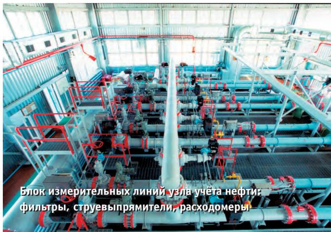
Блок измерительных линий узла учёта нефти: фильтры, струевыпрямители, расходомеры
