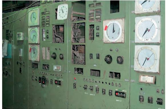
Рис. 9. Щит управления котлом до реконструкции
