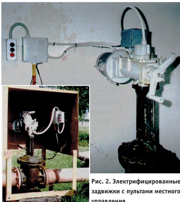
Рис. 2. Электрифицированные задвижки с пультами местного управления
