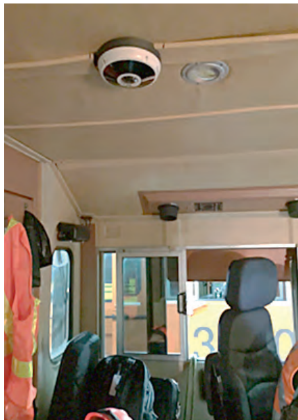
Рис. 9. Установка камер в кабине локомотива
