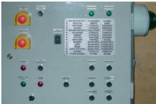
Рис. 4. Шкаф местного управления ПМУ-31
