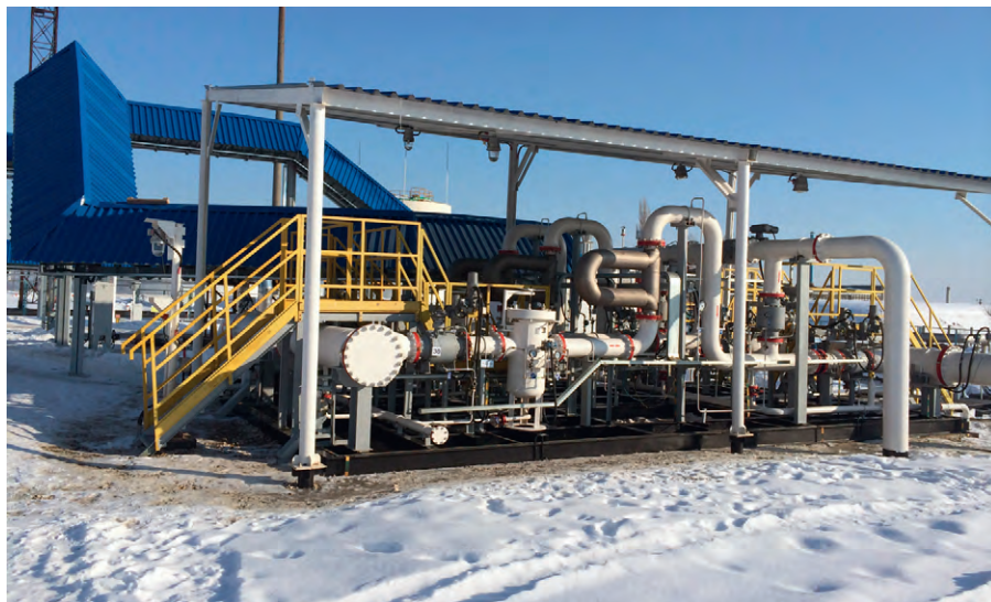
Рис. 1. Узел коммерческого учёта нефти
