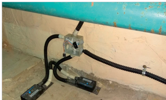
Рис. 14. Иллюстрации возможного крепления датчиков детонации и деформации
