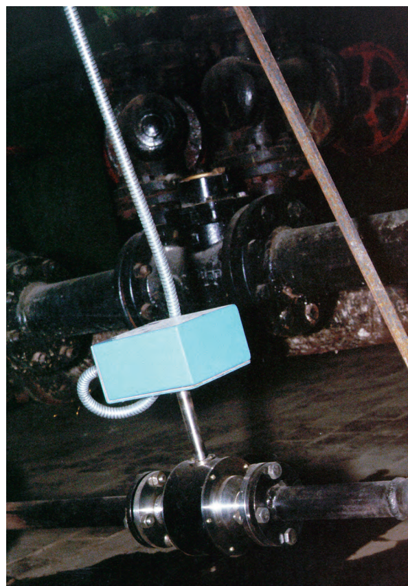
Рис. 3. Первичный преобразователь расхода типоразмера 32 мм
