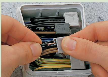
1974 Плоско-пружинные зажимы для распределительных коробок
