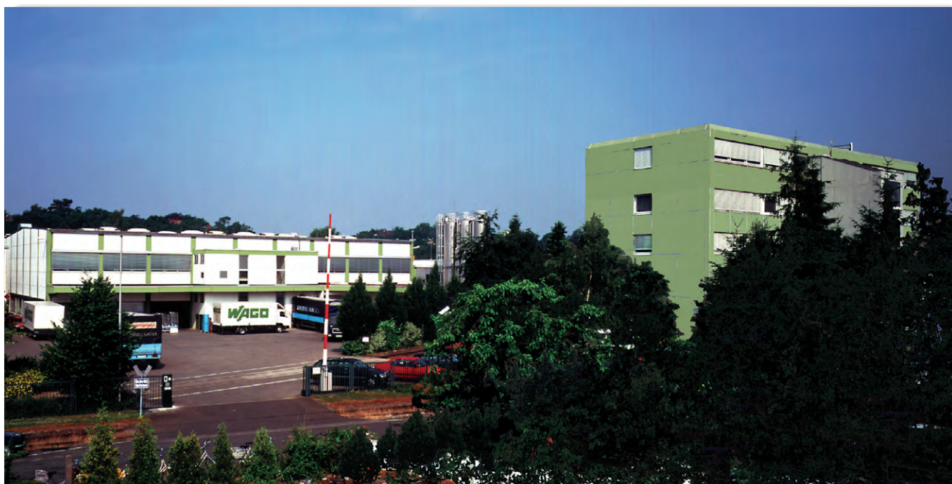
Рис. 1. Штаб-квартира фирмы WAGO Kontakttechnik GmbH и завод в г. Минден, Вестфалия
