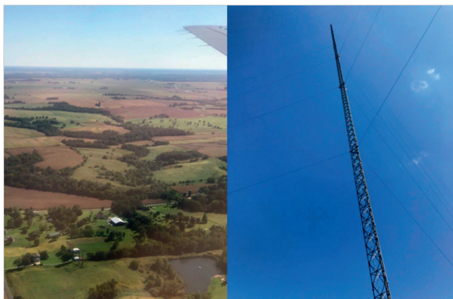
Рис. 1. Ровная сельская местность вокруг участка в Квад-Сити, штат Иллинойс (слева) и 300-метровая телебашня с оттяжками, которая использовалась для экспериментов с покрытием (справа)
