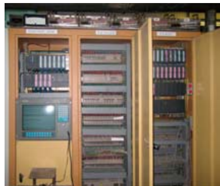
Рис. 5. Шкафы контроллеров «Обжиг» и «Транспорт печи»
