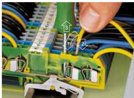
Рис. 4. Использование отвёртки при работе с зажимом CAGE CLAMP®
