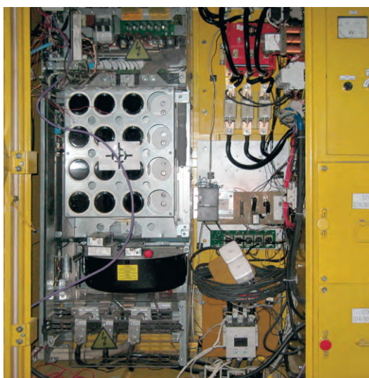
Рис. 9. Частотно-регулируемый привод магистрального конвейера
