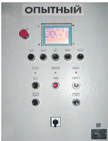
Рис. 3. БУК магистрального конвейера с частотно-регулируемым приводом
