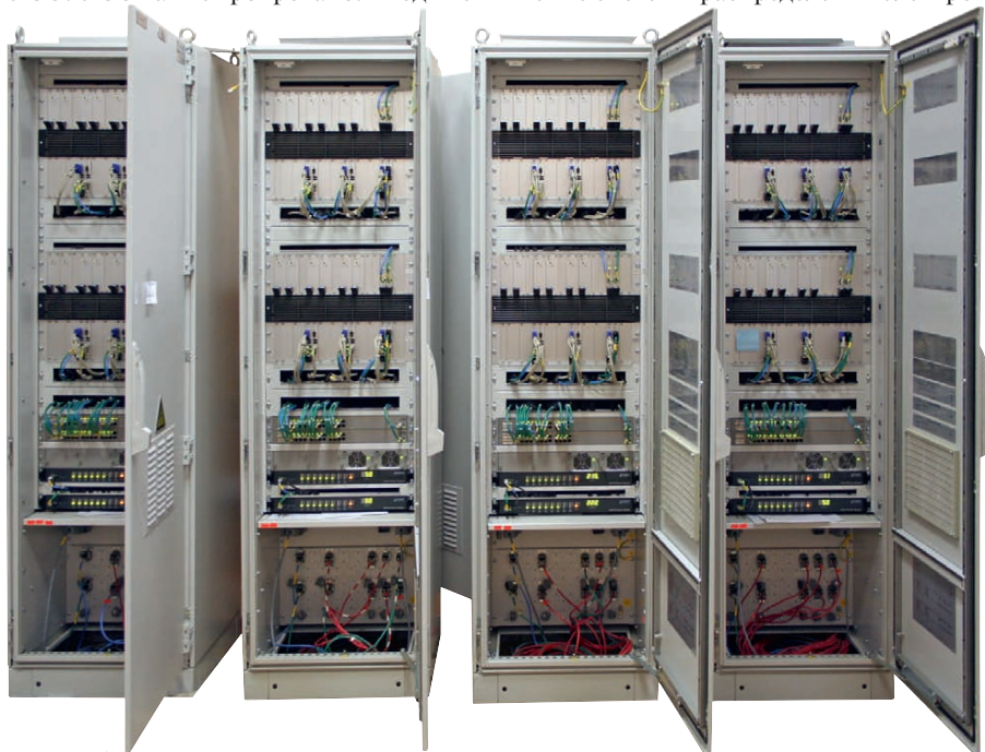
Рис. 4. Оборудование АСУ ТО (этап заводских испытаний)
