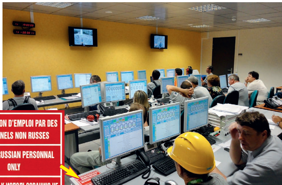
Рис. 6. Зал управления наземным ТО, находящийся в здании командного пункта (идёт имитация заправки РН в автоматическом режиме)
