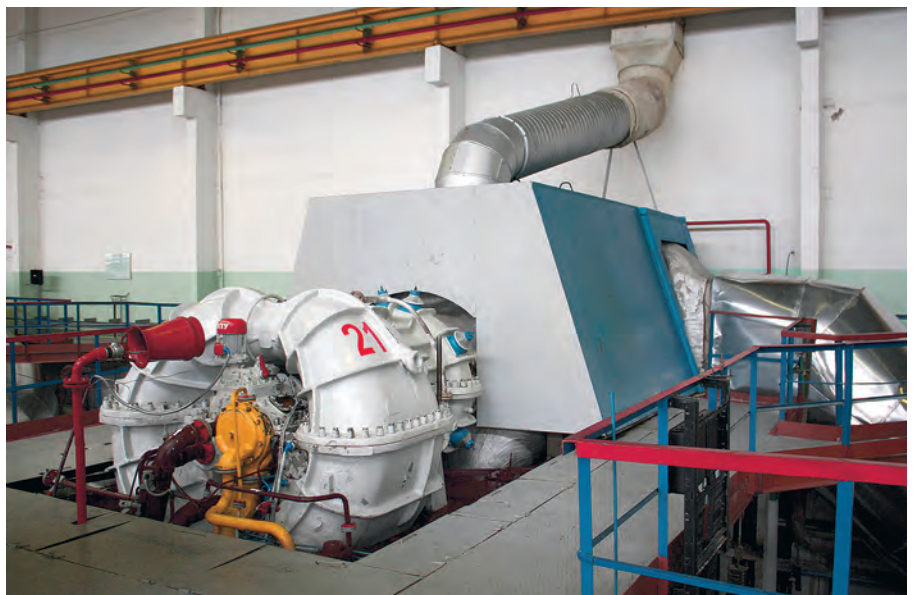
Рис. 6. Объект внедрения – ГПА типа ГТК-10-4
