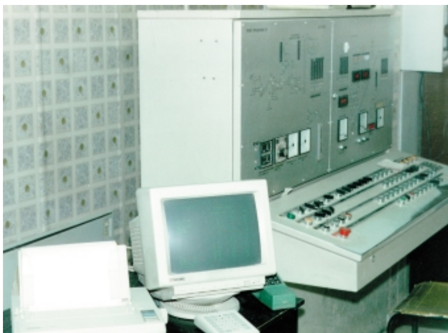
Рис. 3. Рабочее место оператора завода. На переднем плане принтер, монитор и клавиатура, на заднем – пульт управления
