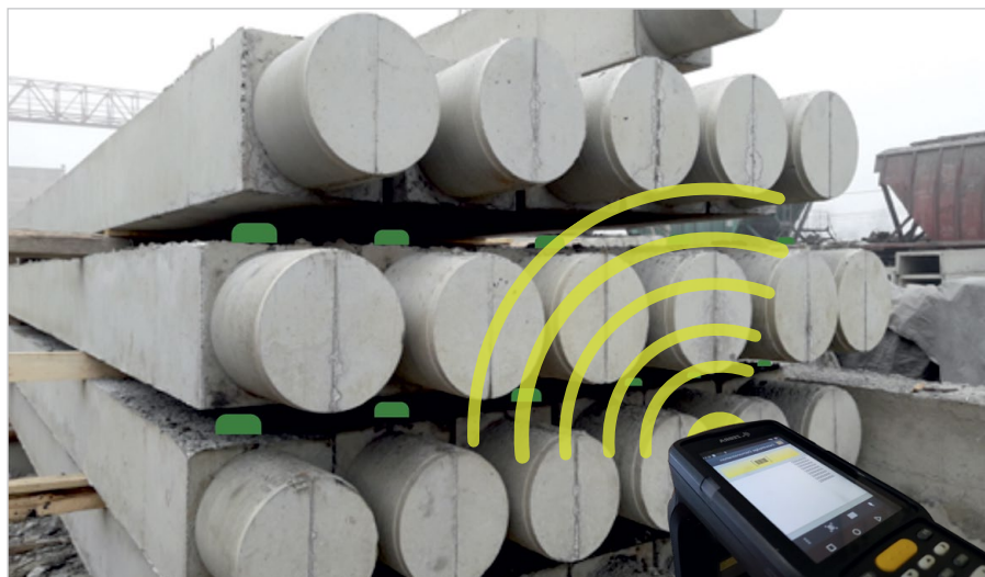
Рис. 1. Сканирование ЖБИ, маркированных RFID-меткой S-TAG B-top, с помощью терминала сбора данных
