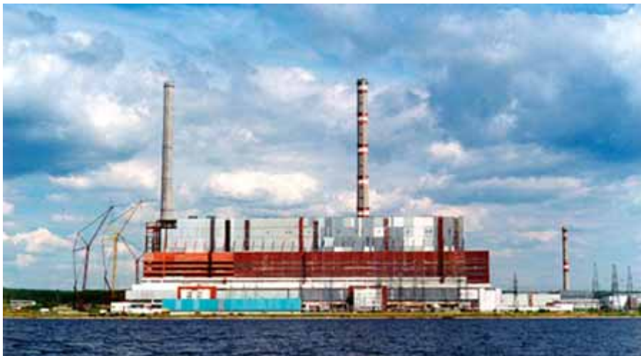
Общий вид Пермской ГРЭС со стороны Камского водохранилища
