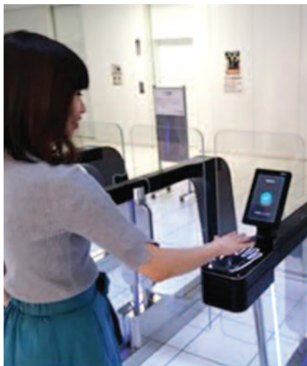
Рис. 7. Испытание биометрической системы на турникетах СКУД
