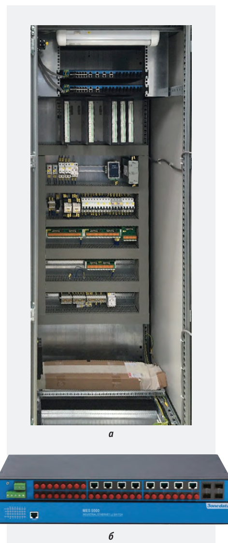
Рис. 4. Коммутатор Zonedata MES5000 для применения на объектах энергетики: внешний вид (а); установка на объекте (б)
