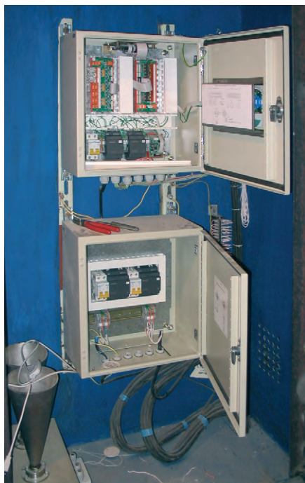
Рис. 5. Монтаж блоков Б1-БАРС 322 и БП-120
