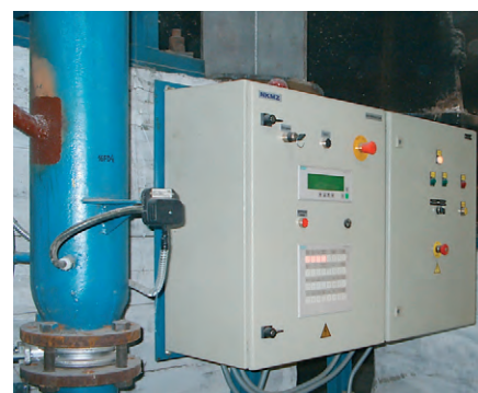
Рис. 4. Пульт управления станком сушки и пульт управления крышкой
