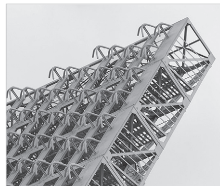
Рис. 14. Участок фазированной решётки антенны РЛС «Воронеж-М»
