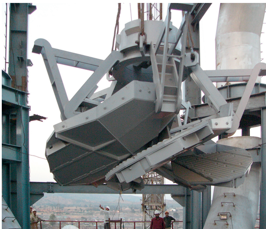
Рис. 1. Роторный распределитель как основная часть РЗУ
