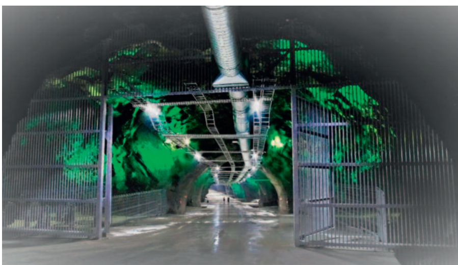
Рис. 8. Протяжённость туннелей в Lefdal Mine Datacenter составляет 28 км
