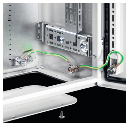
Рис. 13. Заземление монтажной панели после сборки
