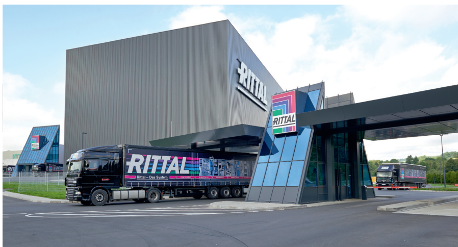
Рис. 1. Завод Rittal в г. Хайгер
