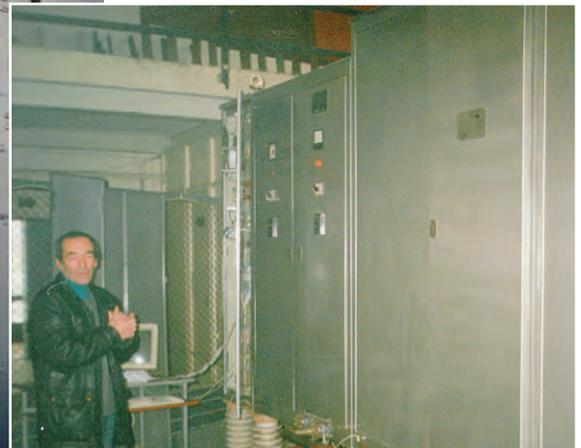
Наладка регулируемого синхронного привода
