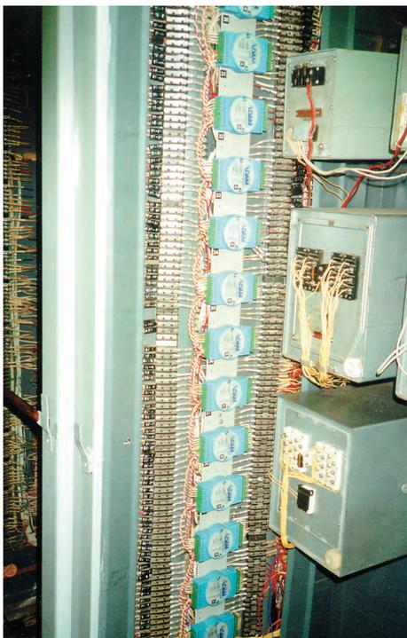
**Рис. 3. Монтаж модулей ADAM-4000 в приборной панели**
