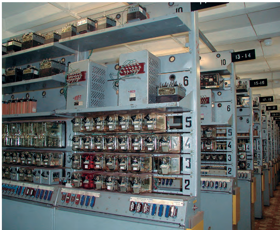
Рис. 2. Общий вид помещения АТП (аппаратуры телемеханики и управления движением поездов) со старым оборудованием (зона ответственности — около 500 м пути в пределах станции и 3 стрелки)
