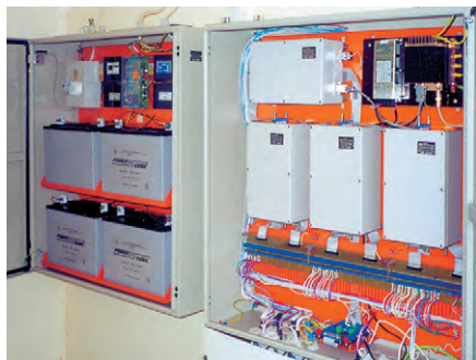
Рис. 5. УСиУ (справа) и УБП (слева) внутри блок-бокса КП
