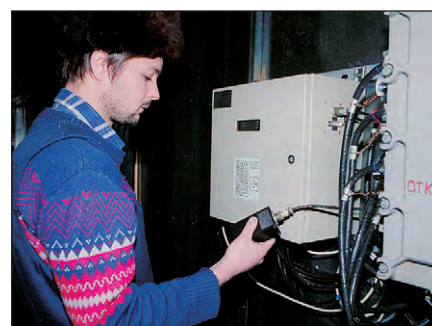
Рис. 5. ИВУ стационарной системы «Поток-3М» в блок-боксе
