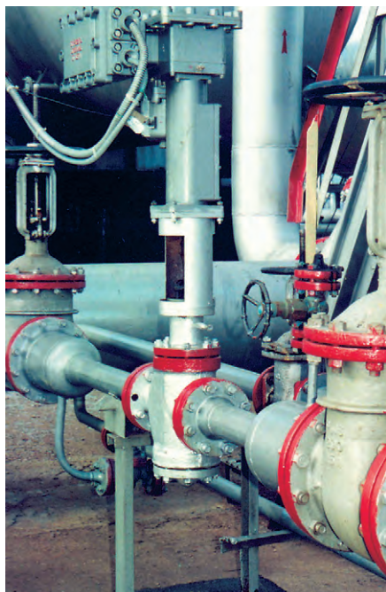
Рис. 4. Исполнительный механизм — электрифицированная задвижка
