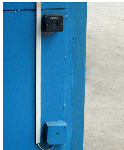
Рис. 4. Приёмник ИК-излучения в защитной металлической коробке и кнопка местного управления
