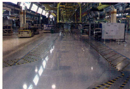
Рис. 2. Покрытие ROMPOX® 1107 ESD на предприятии автомобильной промышленности в Китае
