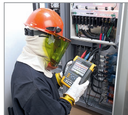
Рис. 3. Работа с осциллографом в высоковольтных цепях
