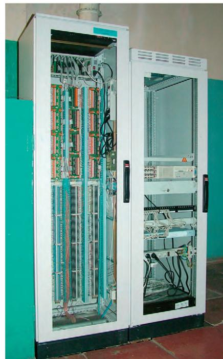
Рис. 3. Шкаф контроллера регистрирующего и шкаф файлового сервера
