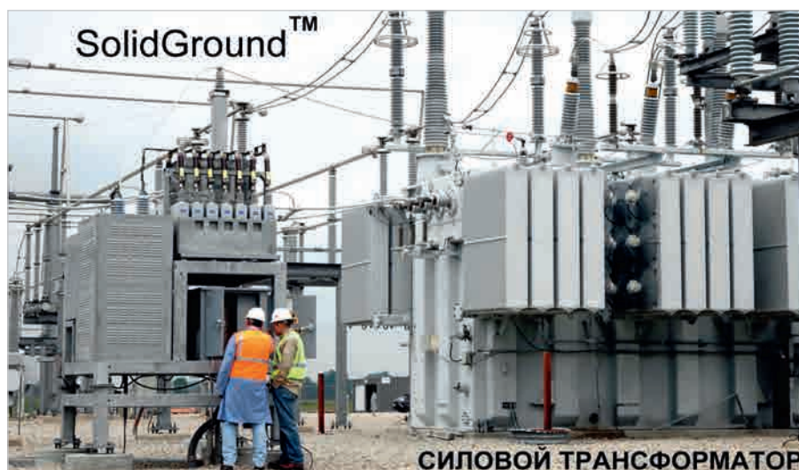
Рис. 2. Устройство SolidGround™ компании АВВ (слева) для блокировки ГИТ в нейтрали силового трансформатора
