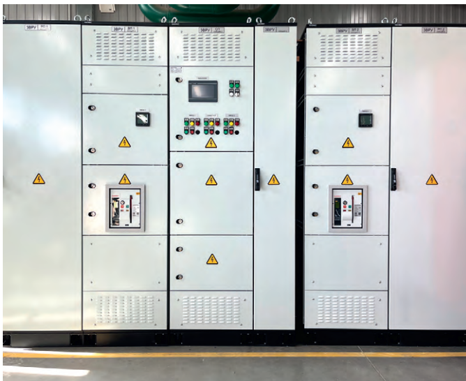
Рис. 1. Система АВР на базе оборудования Митра (Mitra): шкаф с панелью оператора
