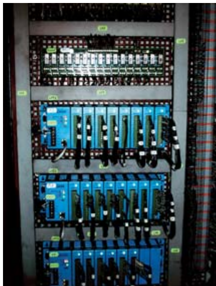
Рис. 3. Шкаф с тремя контроллерами ADAM-5000/TCP (основной, резервный и сбора общецеховых параметров); над контроллерами установлены реле, осуществляющие механическую перекоммутацию каналов ввода-вывода на резервное оборудование
