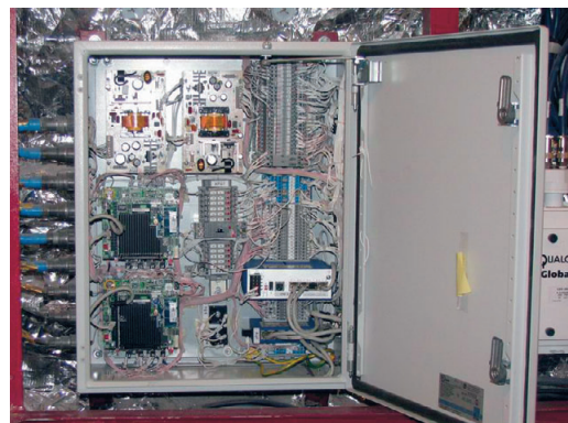
Рис. 14. Шкаф СУИ (дверца открыта)
