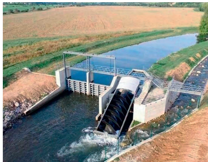
Рис. 9. Вид действующей МГЭС со шнековой турбиной открытого типа
