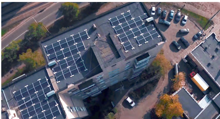
Рис. 15. СЭС на крыше многоквартирного дома в Киеве, 2024 год
