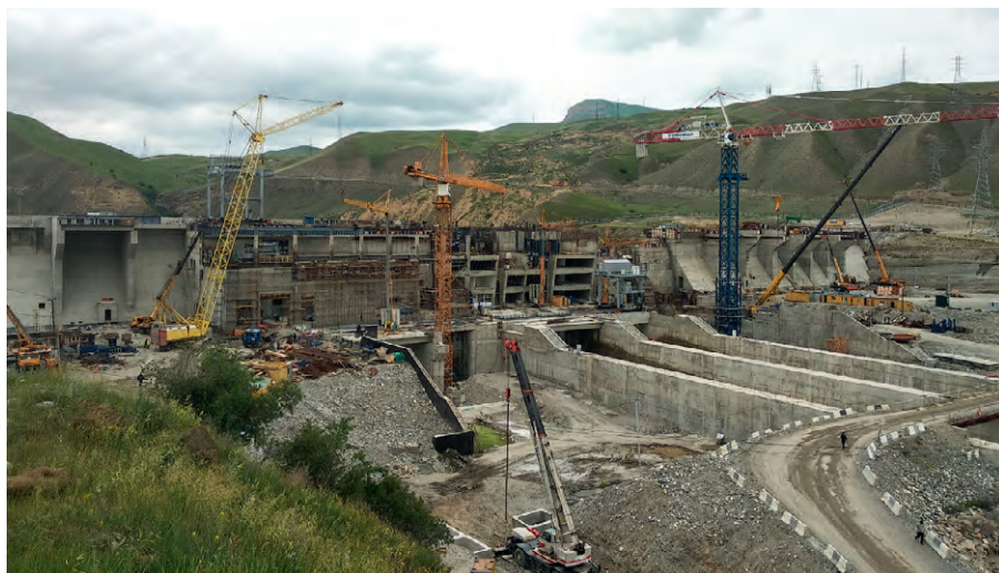
Рис. 14. Строительство Усть-Джегутинской МГЭС
