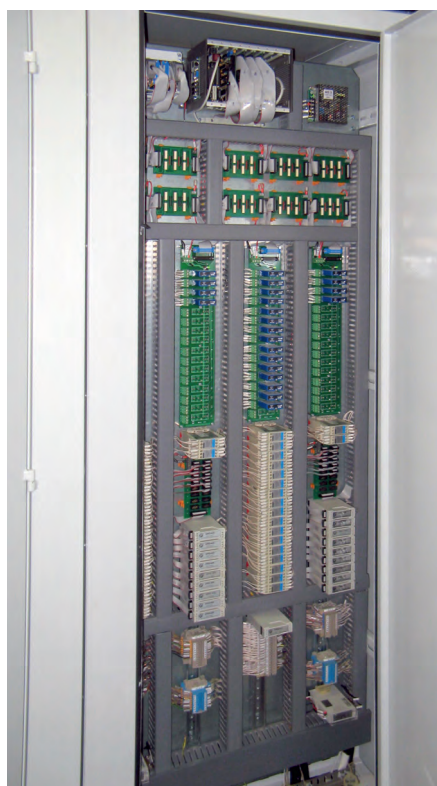
Рис. 4. Монтаж аппаратных средств АСУ
