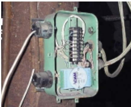
Рис. 2. Распределительное устройство с модулем ADAM-4017
