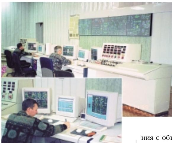
**Рис. 2. Общий вид блочного щита управления (БЩУ) и рабочего места машиниста**
