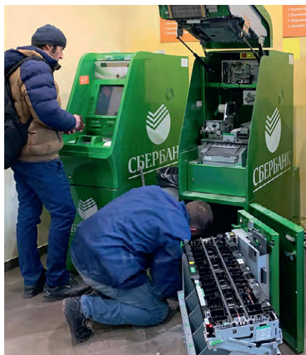
Рис. 2. Иллюстрация регламентных работ в открытой зоне
