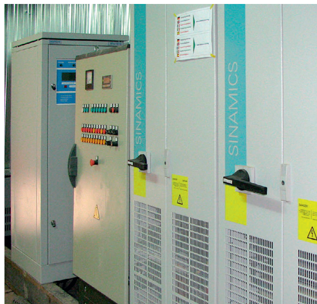
Рис. 4. Частотные приводы большой мощности SINAMICS
