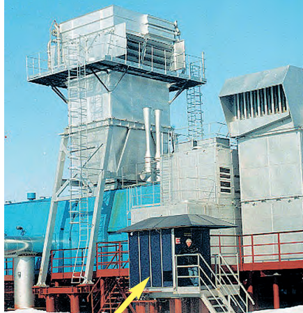
Блок-бокс с аппаратурой САУ размером (2×2×2) м
