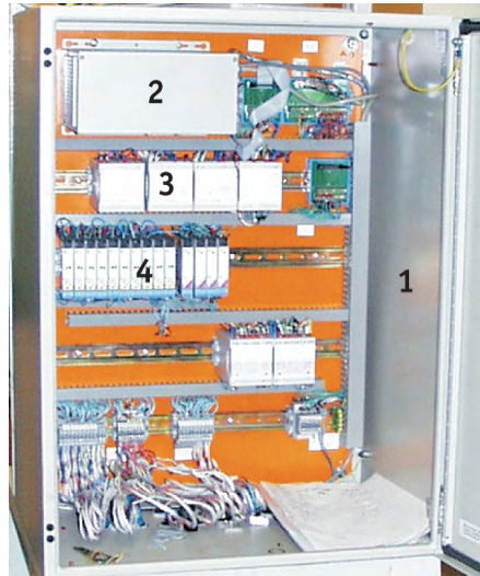
Рис. 7. Локальная технологическая станция системы измерения уровня и температуры (1 — электротехнический шкаф серии CONCEPTLINE фирмы Schrock/Hoffman, 2 — контроллер PCA 6145B в корпусе MBPC641 фирмы Advantech, 3 — блоки питания системы, 4 — барьеры искрозащиты фирмы Elcon)
