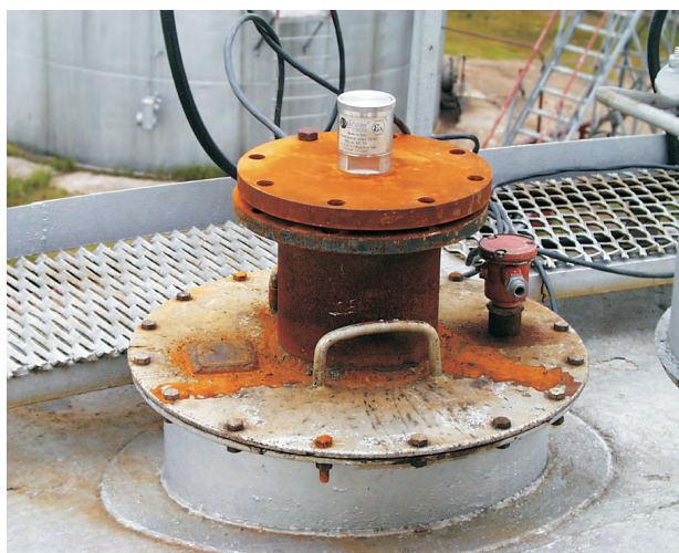
Рис. 5. Размещение уровнемера TS-01 на крыше резервуара
