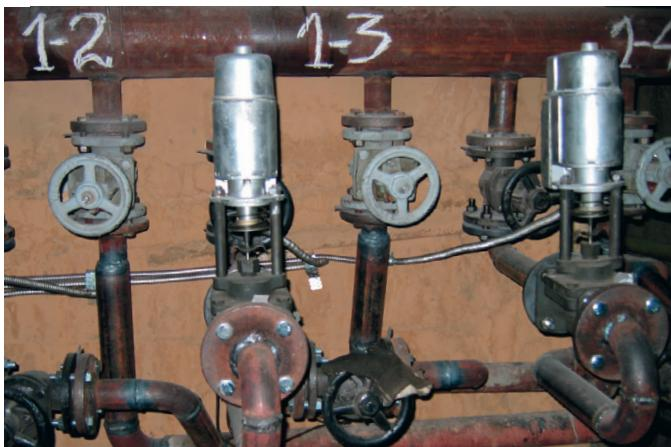
Рис. 4. Электроклапаны, установленные на паропроводе
