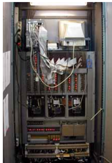
Рис. 5. Промышленный компьютер Advantech в шкафу управления экструзионной линии (вид со стороны задней стенки шкафа)
